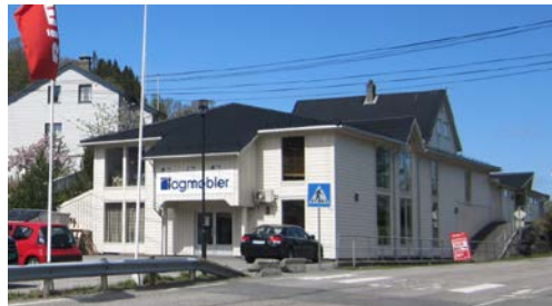
Gang- og sykkelveg aust for møbelforretning
